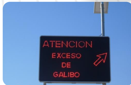
Imagen 1. Ejemplo de instalación con señal led oculta: "ATENCIÓN EXCESO DE GÁLIBO". * El alcance máximo del emisor de radiofrecuencia es de 300 m. en línea directa de visión.
