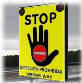
Imagen 1. Ejemplo de instalación del detector en interior de cartel led H.I. Pictograma R-101 y textos: "DIRECCIÓN PROHIBIDA" "WRONG WAY".
